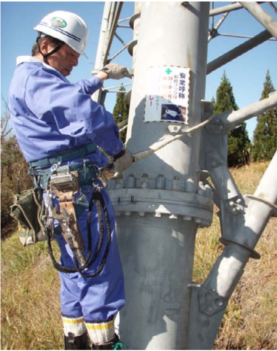
①鉄塔作業時の安全帯胴綱フックが確実に安全帯のD環に掛かっているかの確認する注意喚起標識
