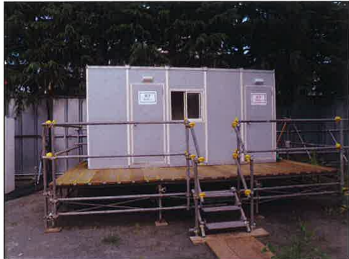
トイレ設置状況
