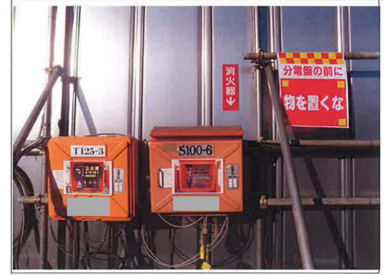
分電盤は内部が分かるように 表示しています。 ①行先表示は必ず付けること。 ②分電盤への接続は有資格者で行う。
