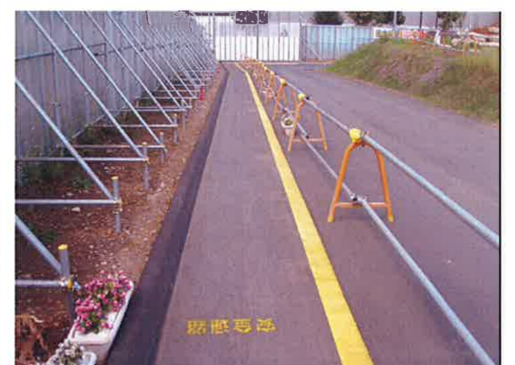
安全通路 ペンキ表示状況②
