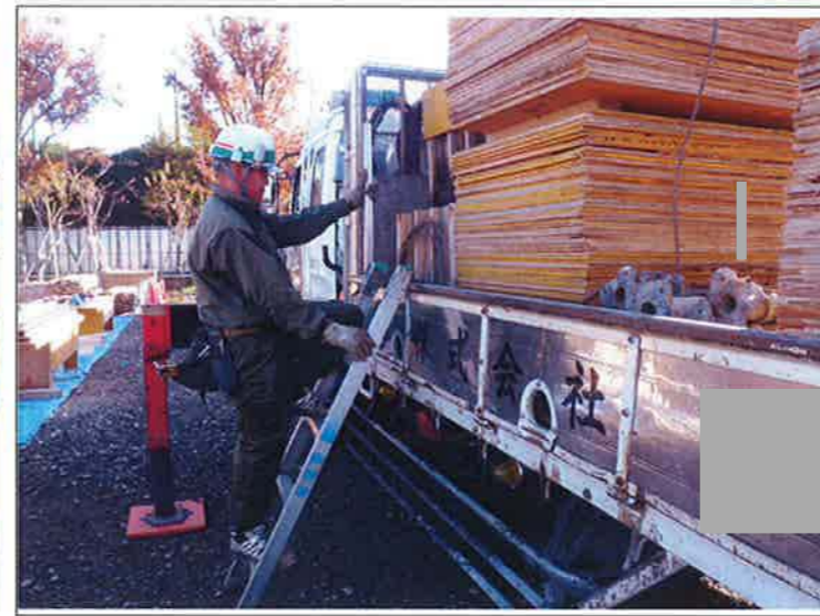
荷台へは必ず昇降用のタラップを使用してください。
