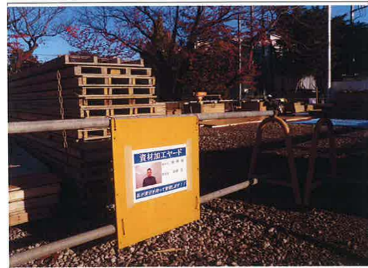
①型枠の加工ヤードです。 ②整理・整頓、飛散物のないように管理すること。
