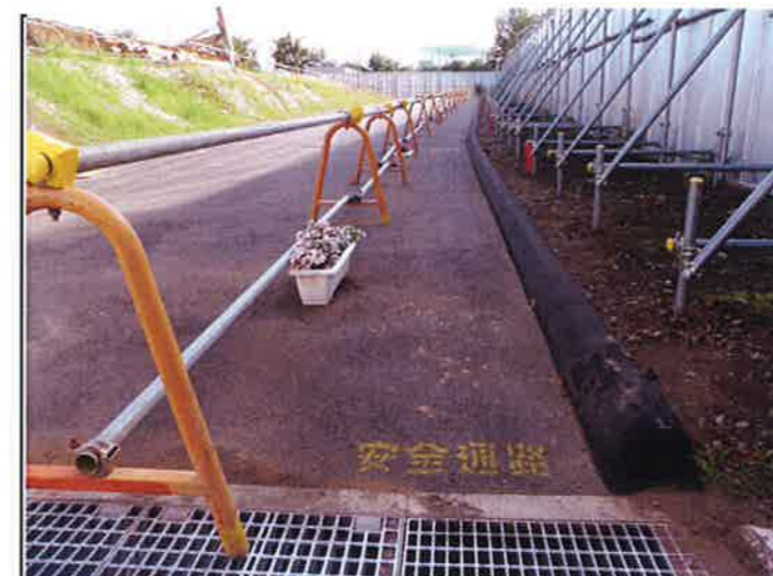
安全通路 ペンキ表示状況①
