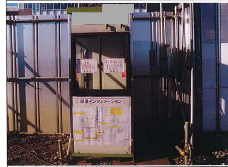
①ガードマンBOXです。 ②現場インフォメーション掲示しています。
