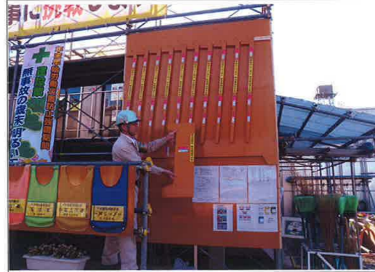
①躯体品質管理の掲示板です。 ②重要な管理項目が掲示しています。
