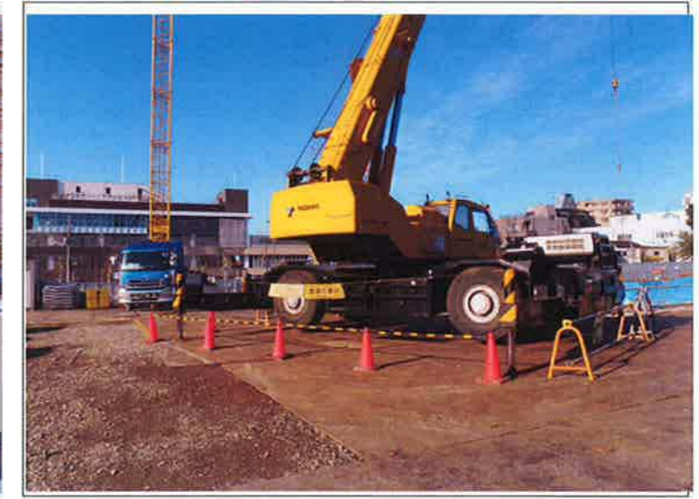
ラフタークレーンの周囲は立入禁止表示をする。
