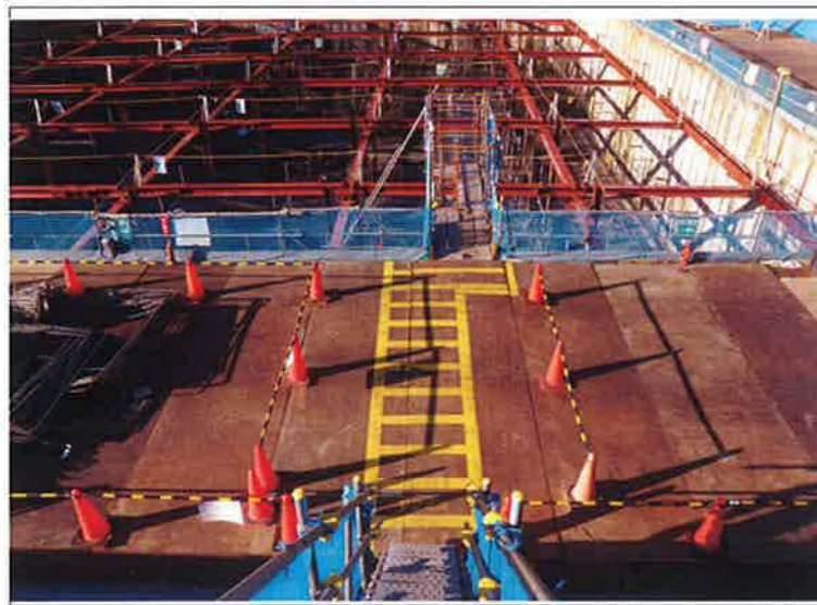
体育館棟地下へ行く安全通路です。
