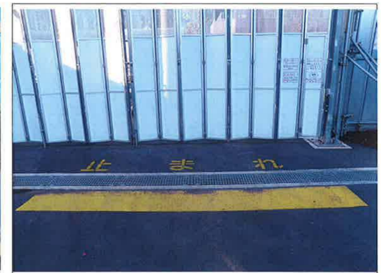
ゲートの向こう側は通行人の 多い歩道です。 ①必ず一時停止すること。 ②誘導員の指示に従って退場すること。
