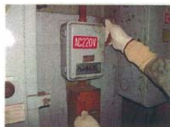
①切断機の前電源を切る。
