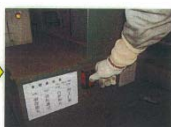
⑫操作スイッチを入れ試運転をする。
