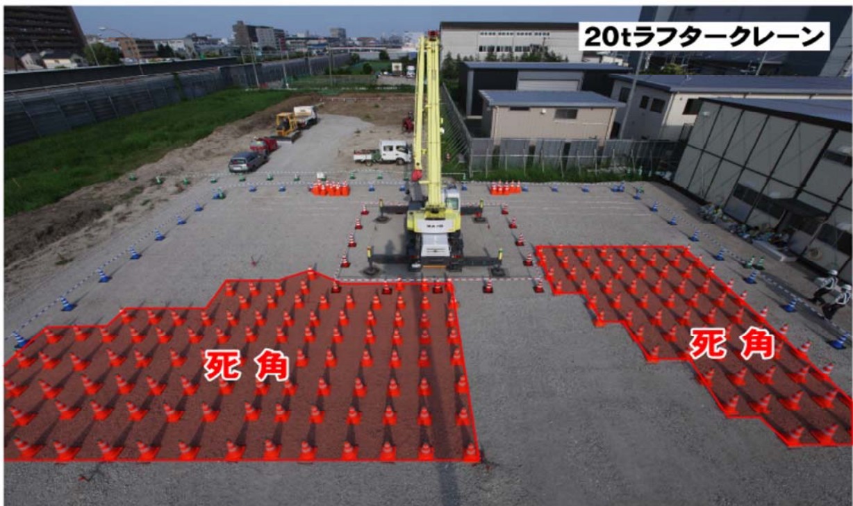
20 tラフタークレーンの死角の見える化
