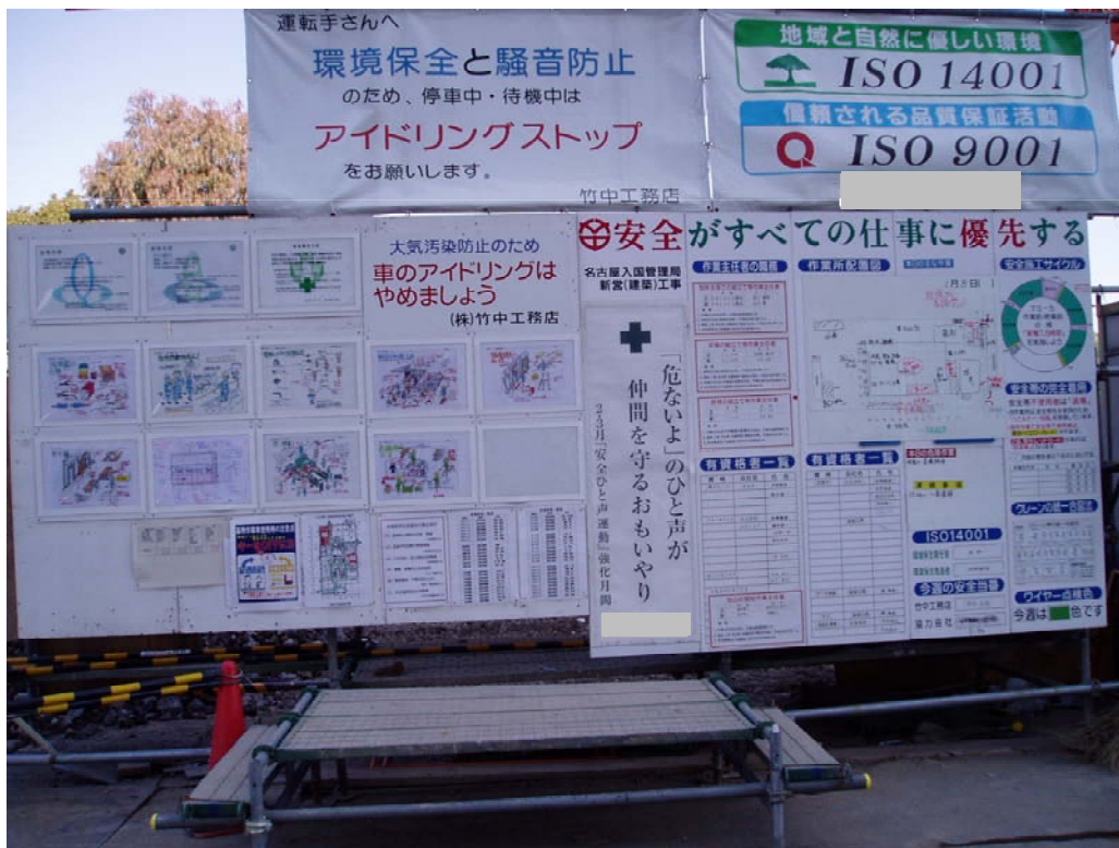
安全絵コンテによる作業手順を朝礼看板に掲示
