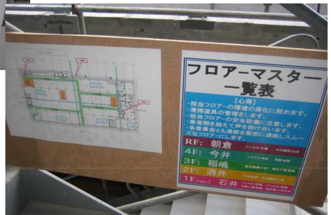
各フロアの安全通路及び避難階段の明示とフロア担当者の掲示
