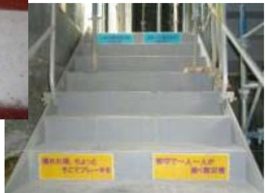
階段蹴上げ部に作業員の作った安全標語を貼り、 階段注意標示と安全意識の啓蒙
