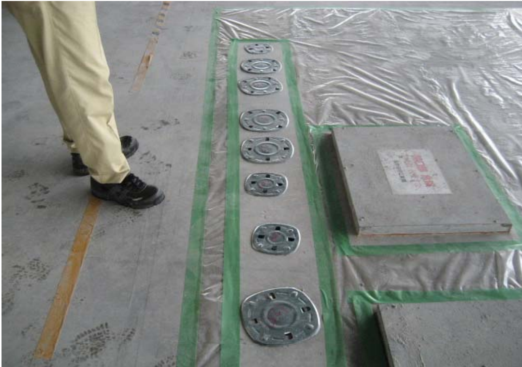
床の開口・スリーブ孔の養生と開口部の明示
