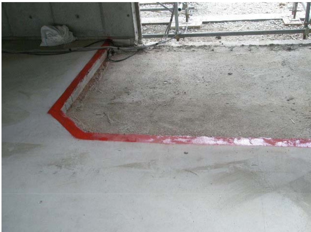
入り口付近の床段差部の明示
