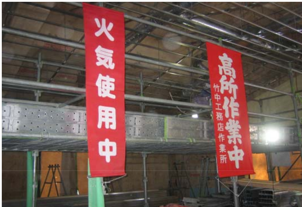
高所作業・火気使用作業中であることの注意喚起幕
