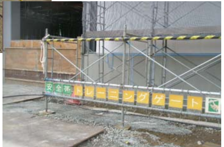
安全帯の正しい使い方をトレーニングする作業所内仮設施設
