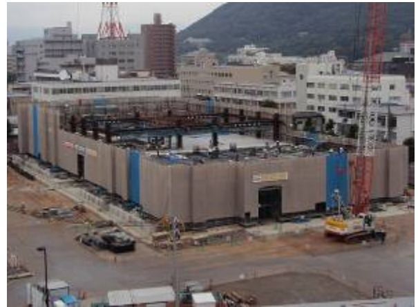
写真-11 ブルーのシートが昇降設備の場所
