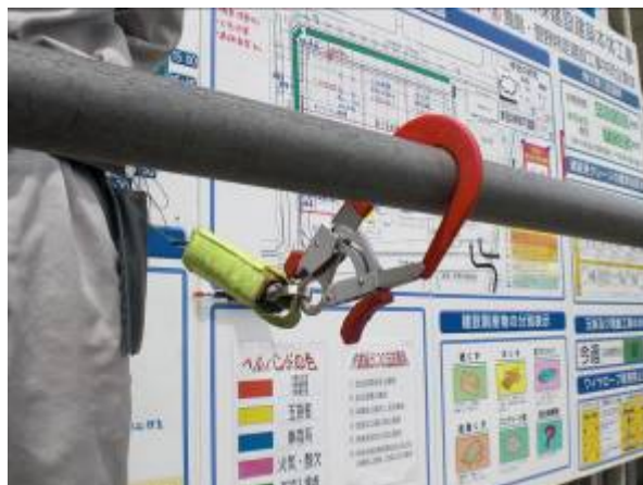
写真-8 安全帯蛍光カバーと朝礼時使用状況
