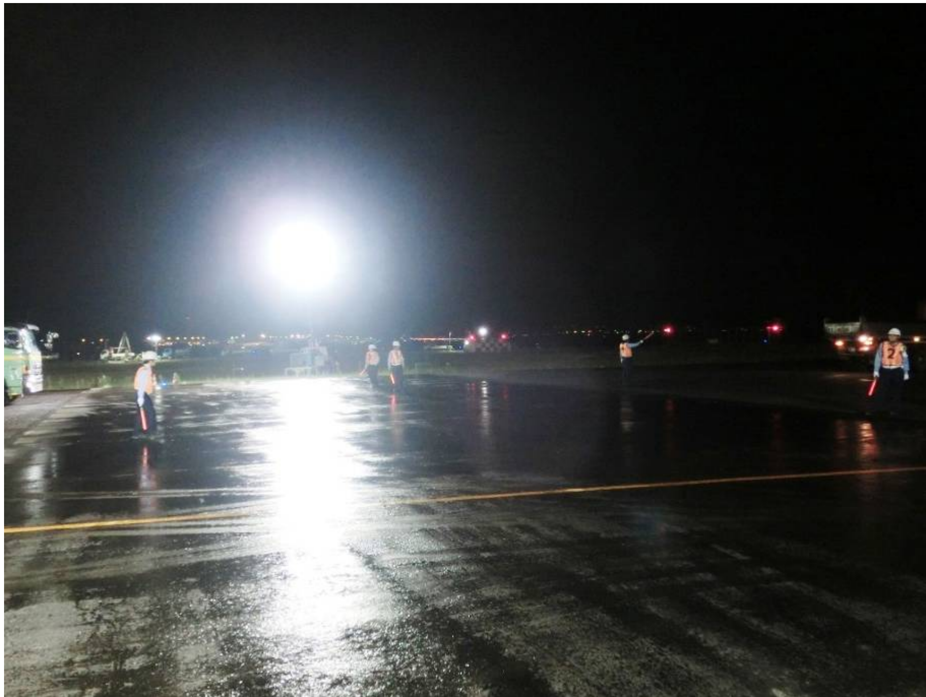
レベリング 3-3 合材ダンプ誘導状況(4)
