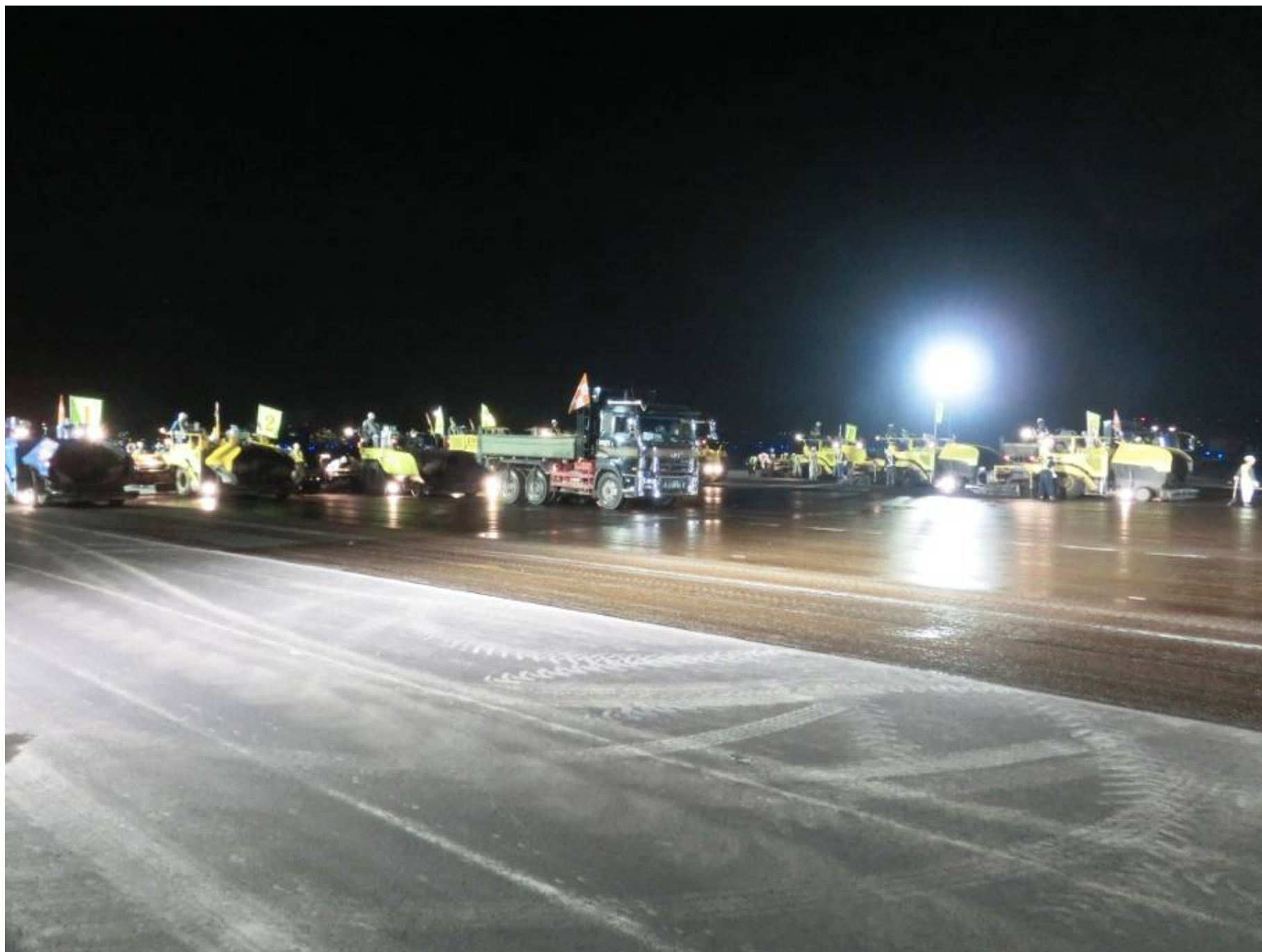
レベリング 3-3 合材敷均し状況. (4)
