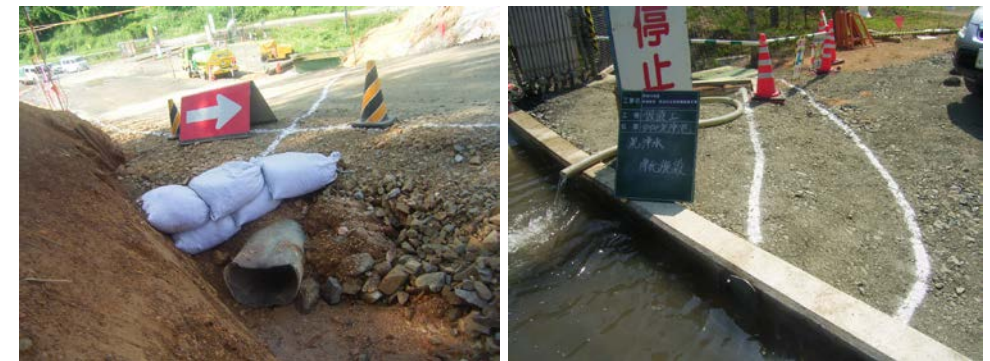
地下埋設物（仮設管）箇所のマーキング
