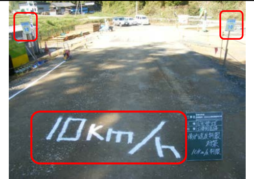
場内速度制限対策 技術提案事項 施工時の安全対策 場内制限速度 10km/h以内
