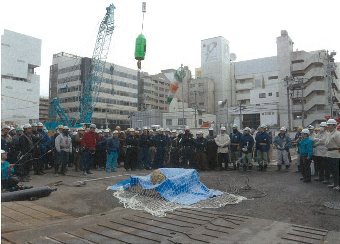
安全带切断の落下状態
