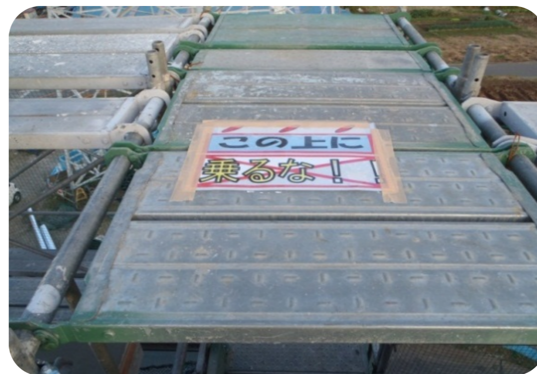
見える化対策④ (外部足場最上部を道板にて塞ぎ、上部への材料突出し、作業員の近接を防ぐ)
