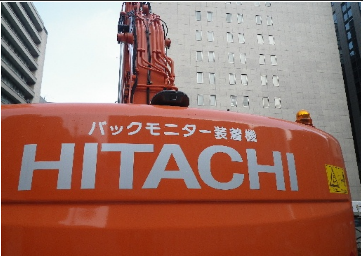
全解体重機 バックモニター装着機の採用
