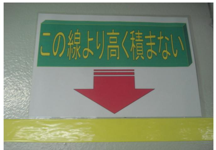
高さ2m以上の荷積み、降ろしの作業は、はい作業に当たるため、2mの所に黄色のテープを貼り、この線より高く積まないよう見える化を図っています。
