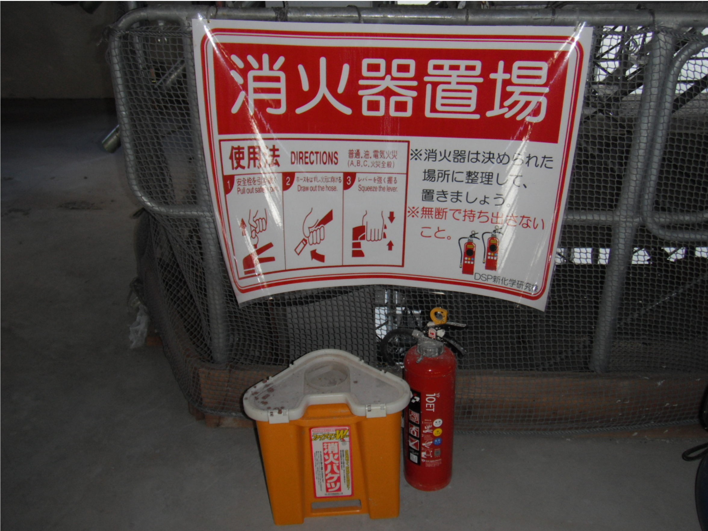
A1サイズの消火器置場ポスターを掲示し、全ての作業員に見える化している
