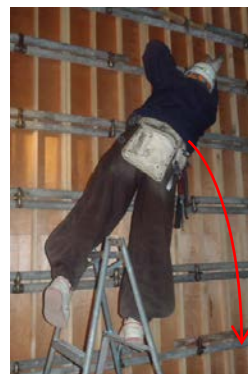
(災害事例) 型枠締付中、転倒 (身を乗り出している作業)
