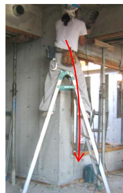
(災害事例) ボルト管撤去中、転倒 (重筋作業)
