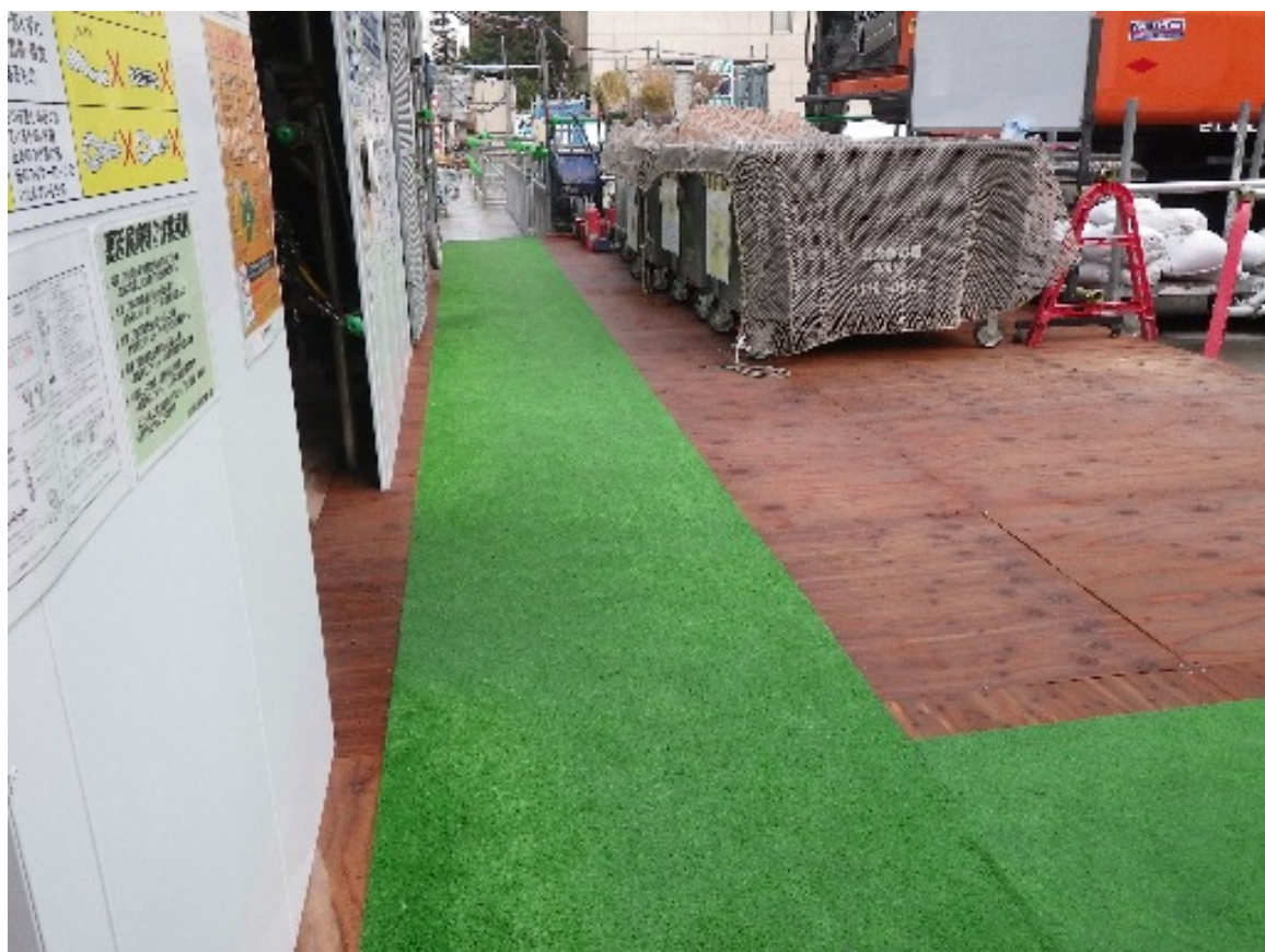
作業通路 床のカラー表示
