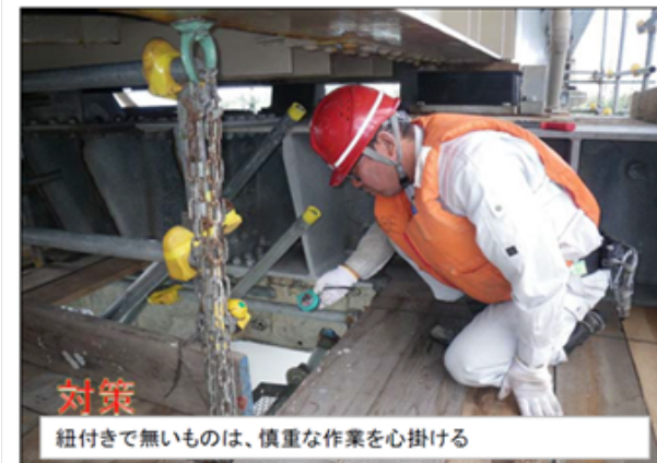
クレーンフックと吊ワイヤーの間に保護手袋が挟まってヒヤリとした
