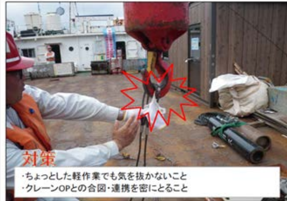
クレーンフックと吊ワイヤーの間に保護手袋が挟まってヒヤリとした
