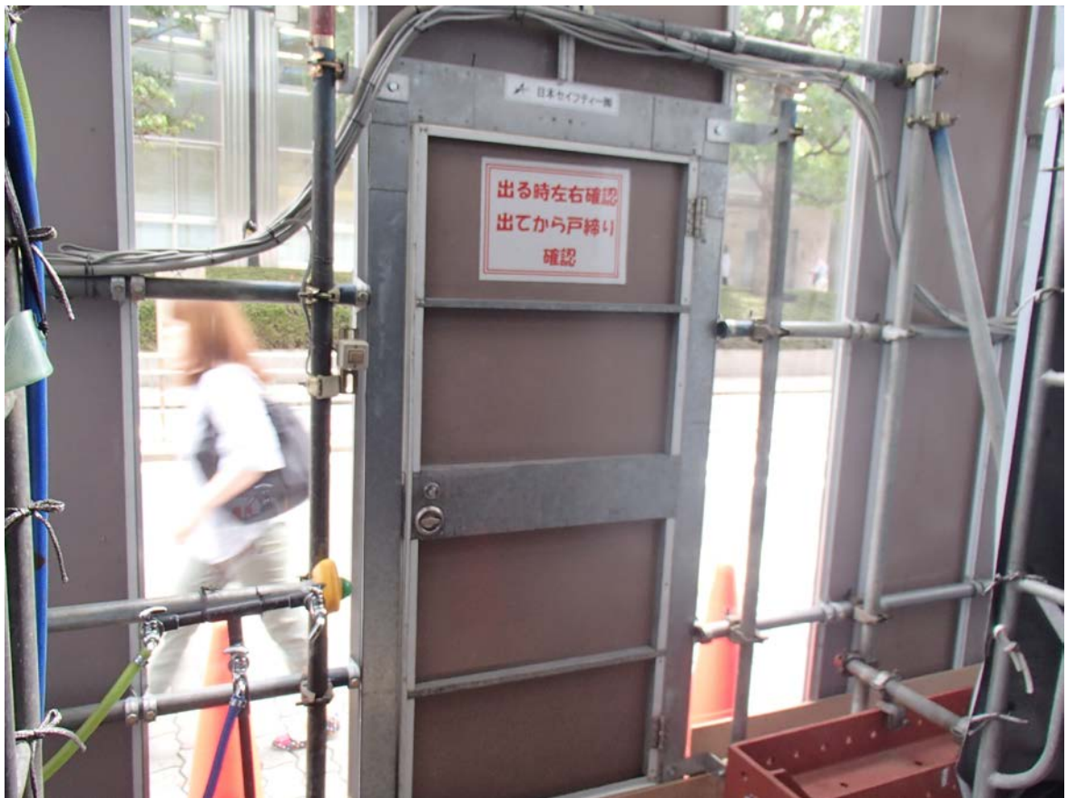
工事関係者出入り口の接触防止の為の工夫（内側）
