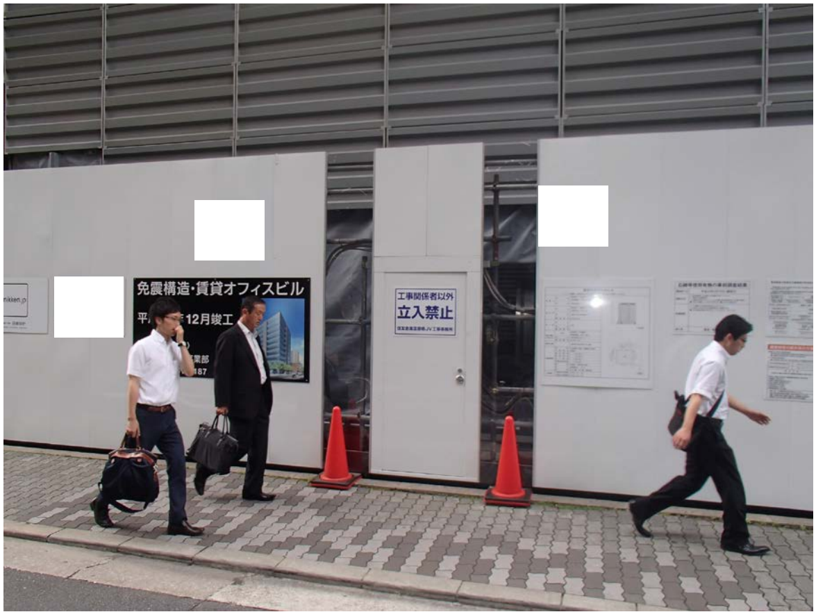
工事関係者出入り口の接触防止の為の工夫（外側）
