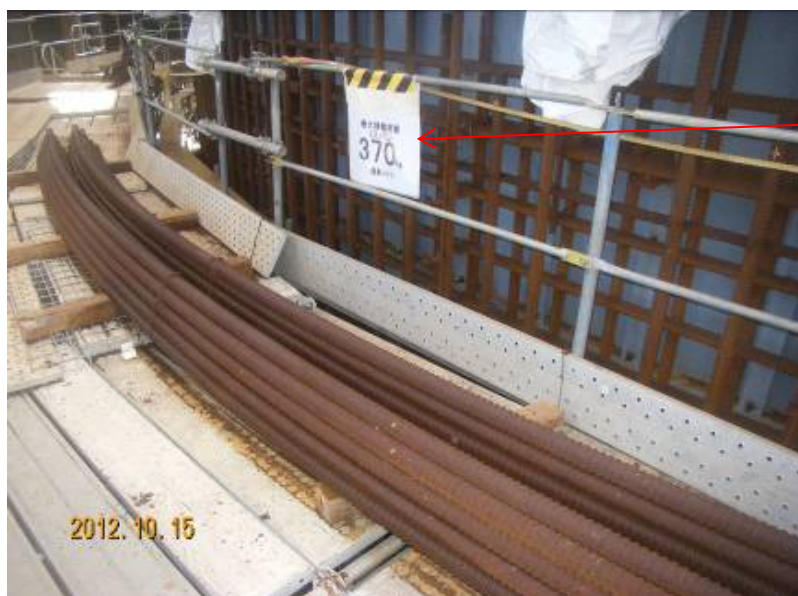
足場上の積載表示(鉄筋の数)仮置き状況
