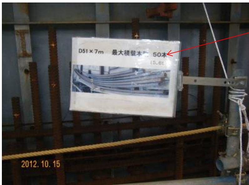
足場上の積載表示(鉄筋の数)
