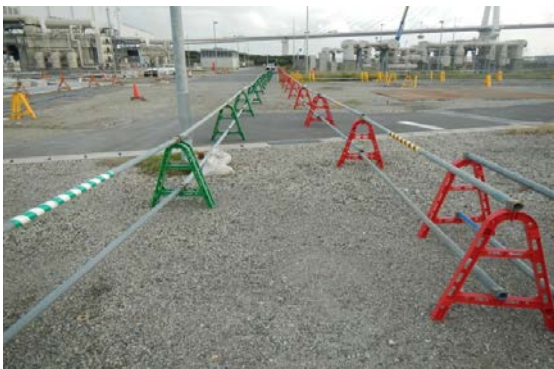
左側:安全通路明示
