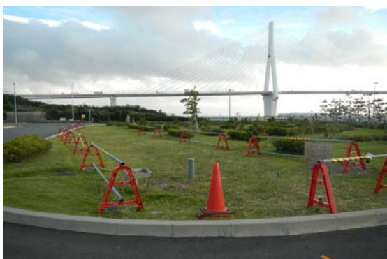
重要埋設物上の立ち入り禁止区域の明
