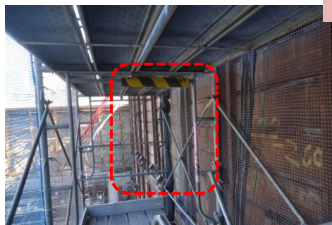
枠組足場に保護、視認性向上のためのトラカバー設置+手掛部に養生テープ貼り
