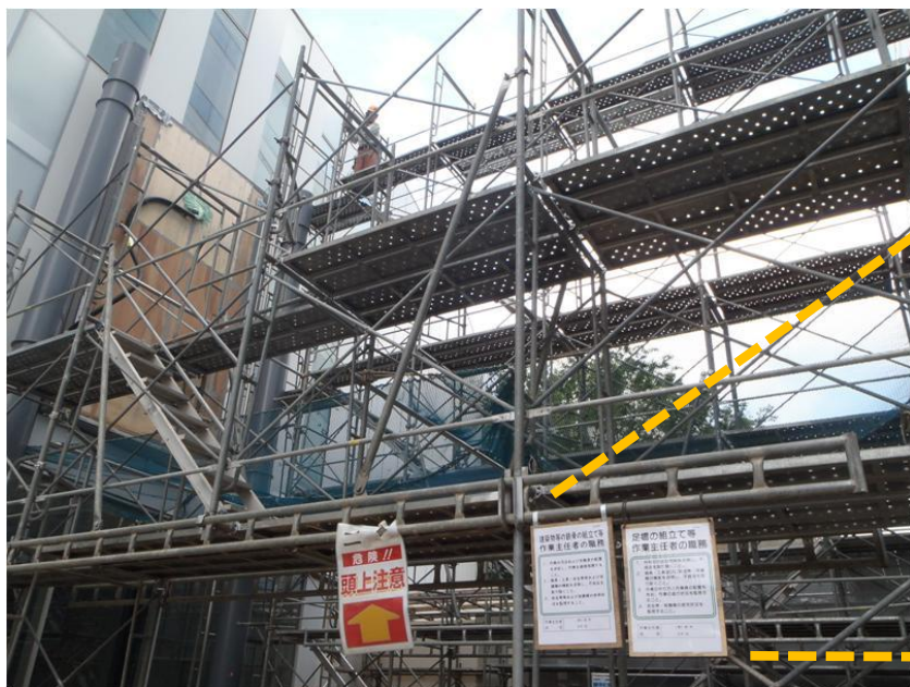
鉄骨・足場組立て作業時の作業主任者掲示
