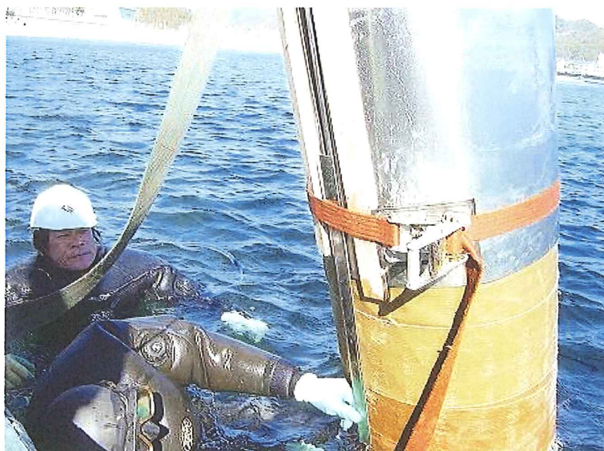
チタンカバー取付状況
