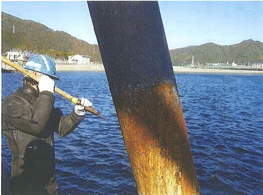
下地処理状況
