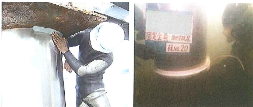
チタンカバー固定金具およびエポキシ樹脂充填状況
