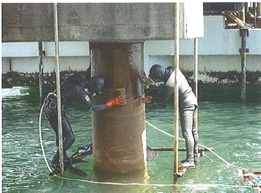
ペーस्टテープ取付状況
