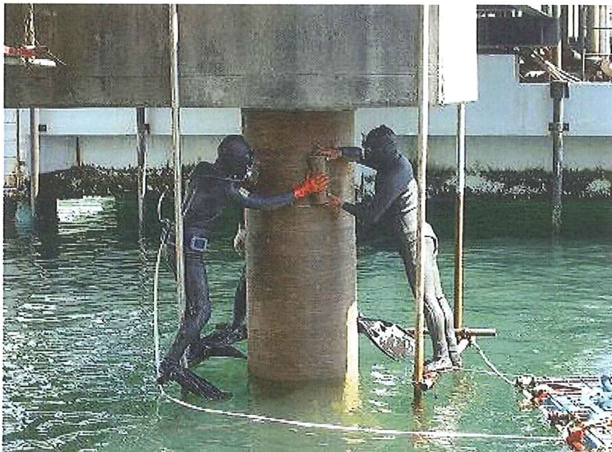
防食テープ取付状況
