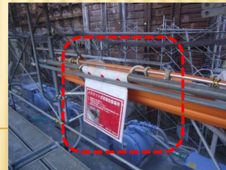
緊急用担架設置
