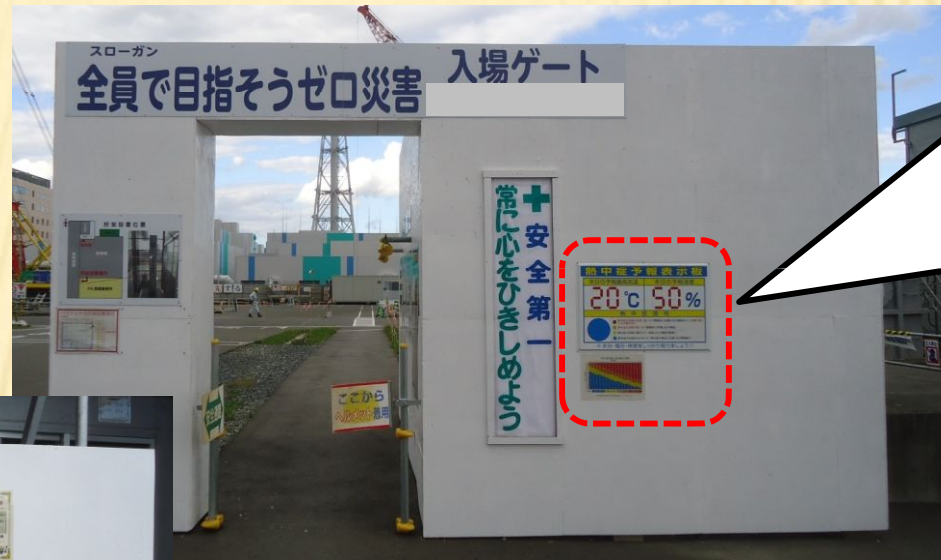
熱中症予報表示板の設置
