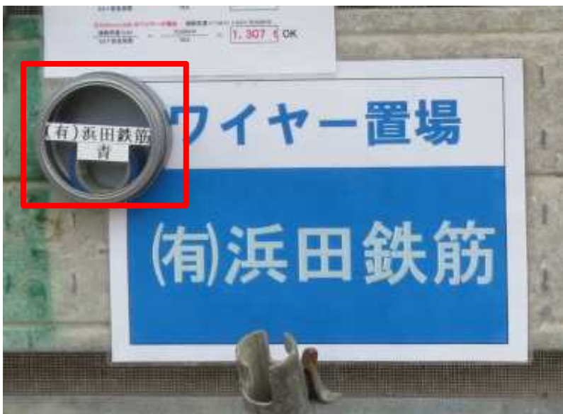
③-3 玉掛ワイヤーの管理状況拡大 (協力会社別点検色テープを玉掛ワイヤー置き場にマグネット付きBOXに入れて使う度にテープが見える様になっている)
