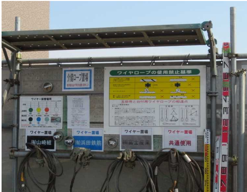
③-1 玉掛ワイヤーの管理状況
