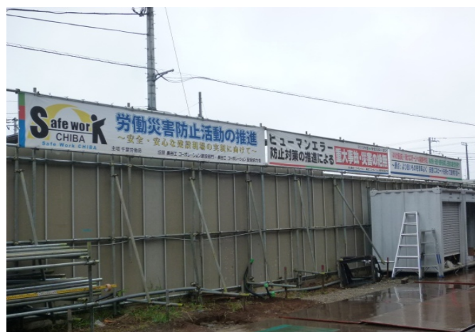
杭工事のため、仮囲い上部に掲示
