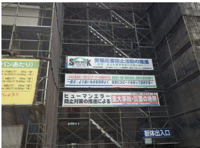
外部足場の目立つ位置に掲示
