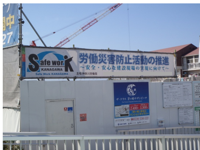
作業員通用口上部に掲示
