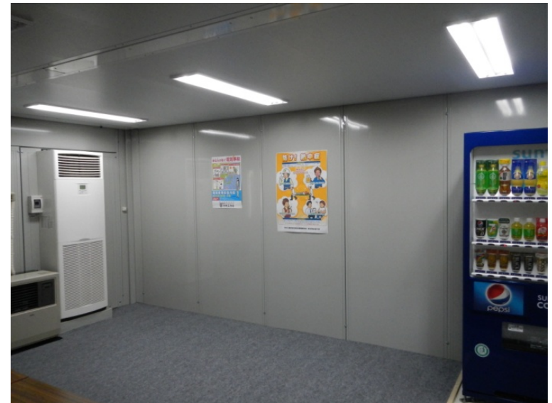
熱中症対策周知掲示（休憩所）状況
