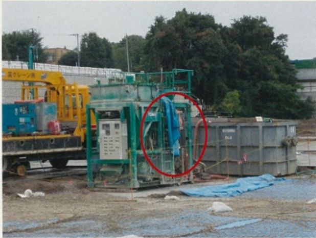
作業終了時、 このシート、飛散注意 (日曜日もこの状態でした)
