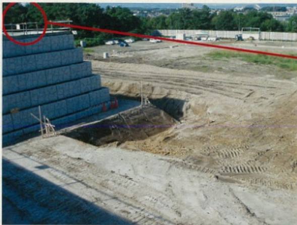
掘削時のルール 昇降設備と周囲の手摺
