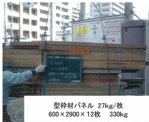
型枠材パネル 27kg/枚
