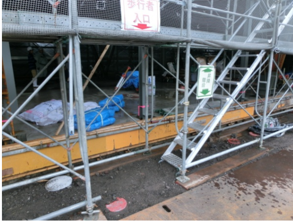
⑤ 外部足場昇降口の「見える化」
