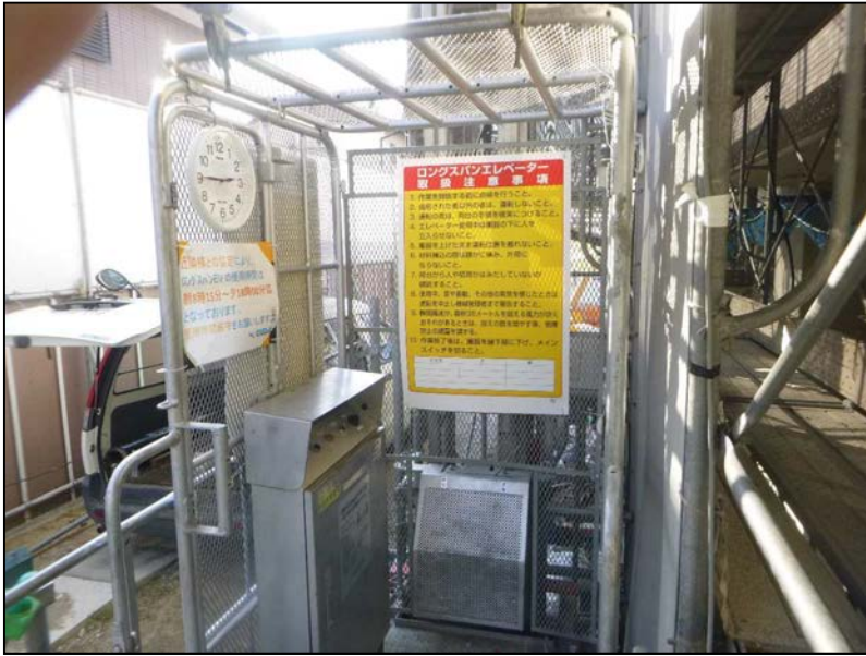
④-1 ロングスパンエレベーター操作台正面に 近隣協定による使用時間の掲示と 時計の設置状況
