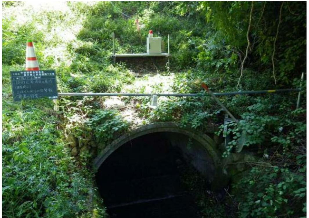
水路上部のバーに超音波センサーが設置されていて水位が一定以上上昇すると、後部の発信機から下流の警報装置及び登録してある携帯電話に通報される。
