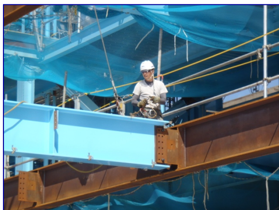
鉄骨建方 by 榎谷組 田阪さん
