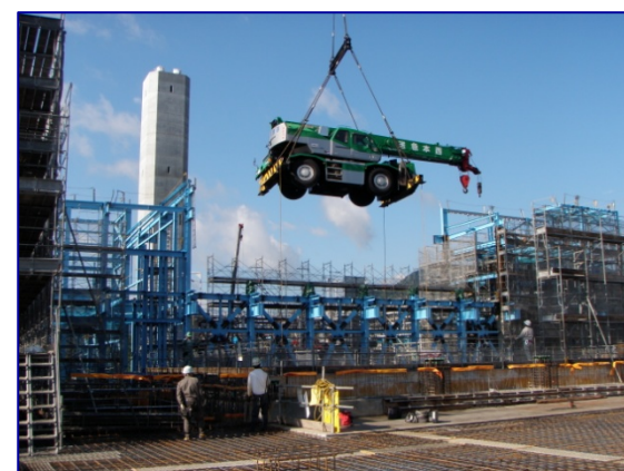
25tラフター揚重 by プラント
