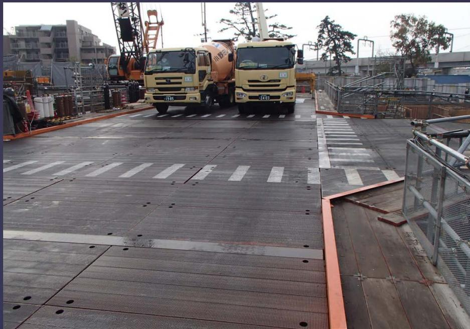
長期間使用するトラック構台の安全通路は誰が見ても明確となるように、区画ラインを鋼材で立ち上げてオレンジ色にペイントすることで新規入場者にもわかりやすいものとしている。
