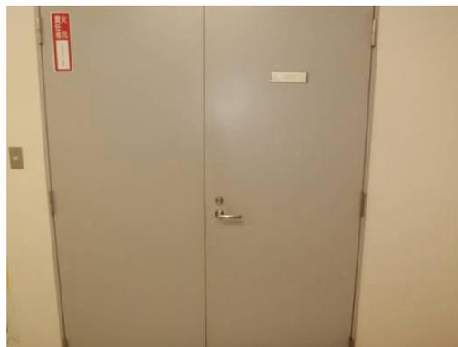
**説明:** 施設内の扉の大半が通路側(廊下)に開く構造となっているうえに窓もないため、扉向こうの人の有無が確認できず通行者と接触するなどのヒヤリハットが多発していた。
