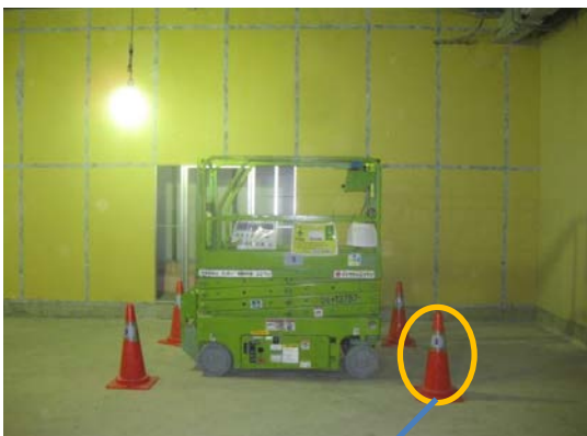
作業エリアの四隅にカラーコーン設置 カラーコーンに管理番号を表示
