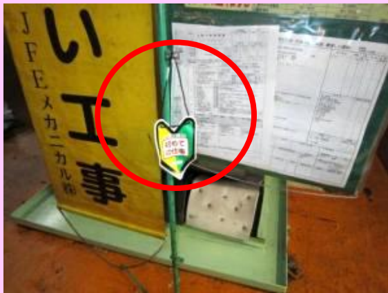
初めての工事指定の見える化
