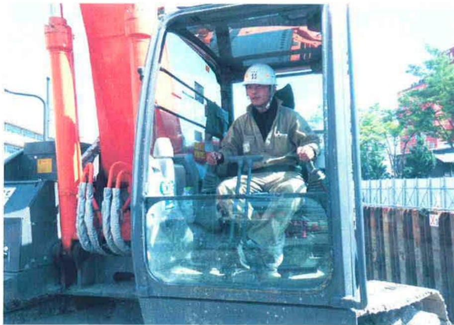
重機シートベルト着用作業状況
