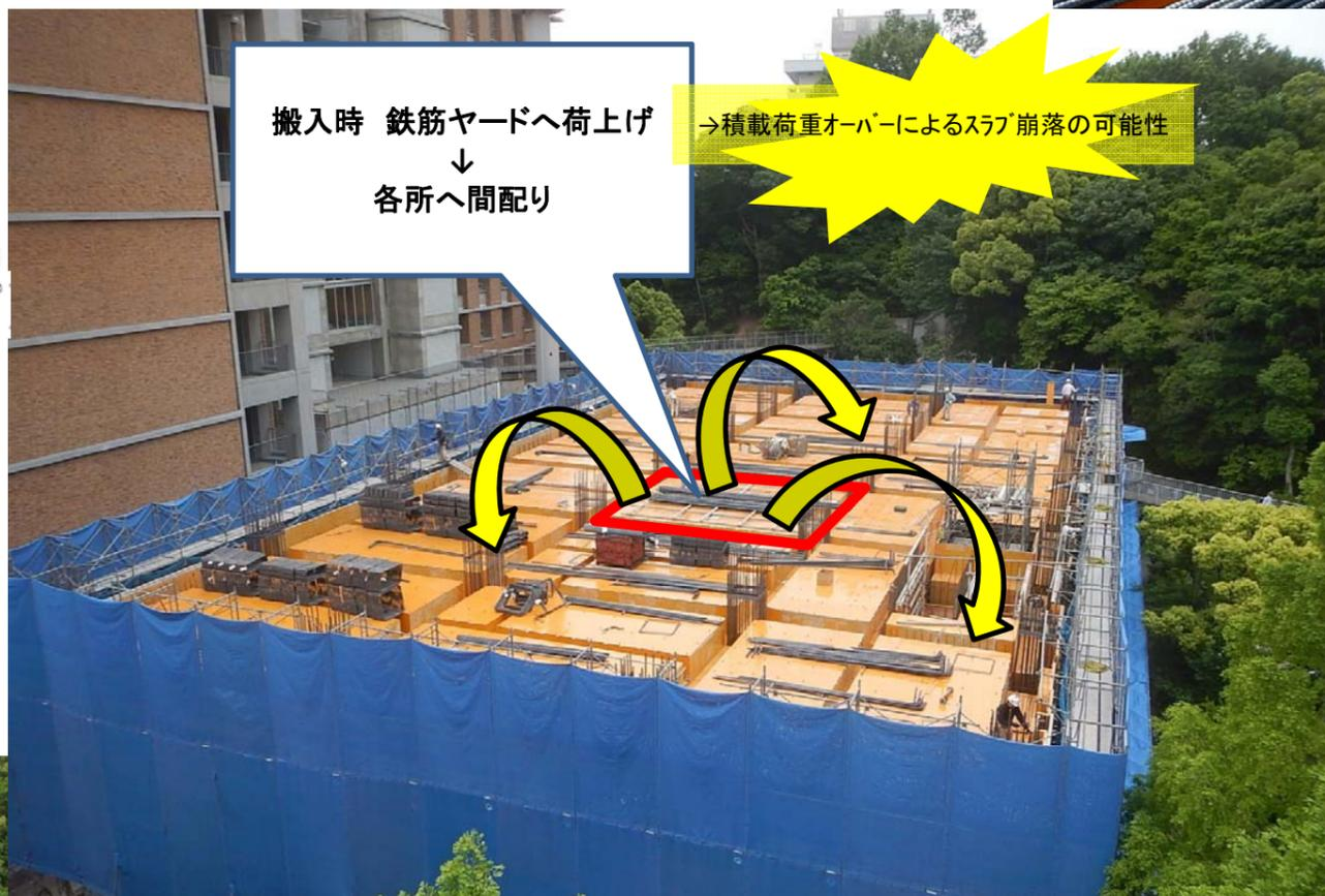
▲鉄筋ヤードに積載荷重と厘木方向の表示
