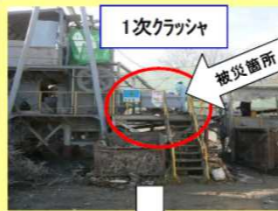
整備中の挟まれ (合図不足による)
