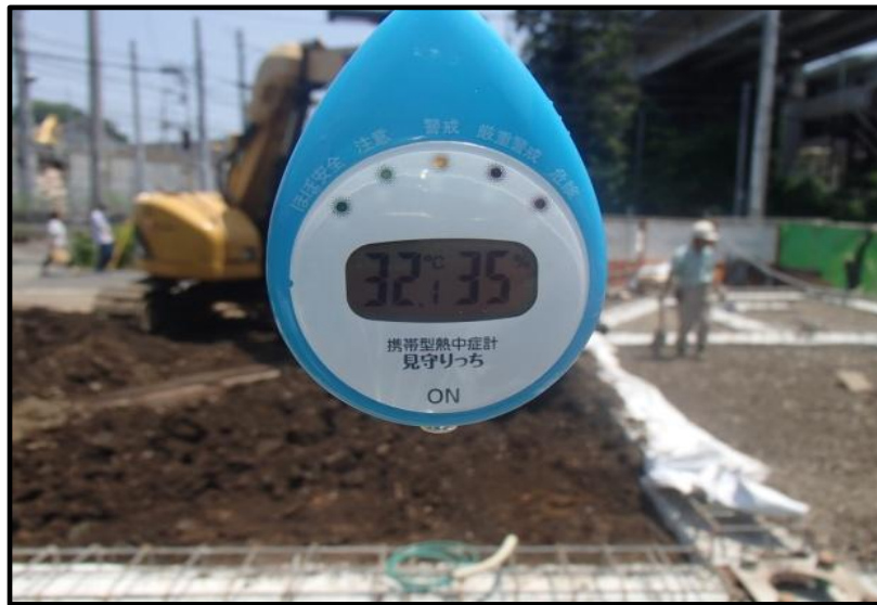
現場での測定状況
