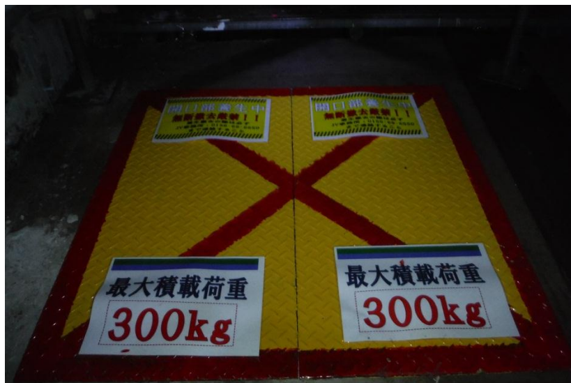
写真⑤ 開口蓋設置状況
