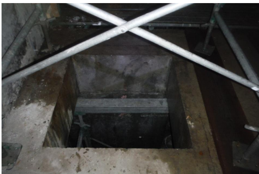
写真④ 開口部養生前状況
