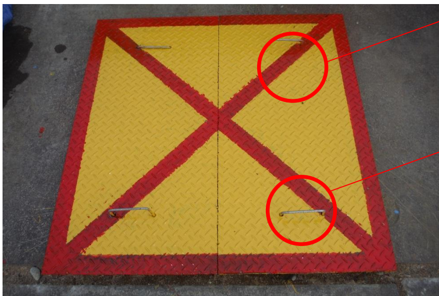
写真① 鉄板への色付状況
