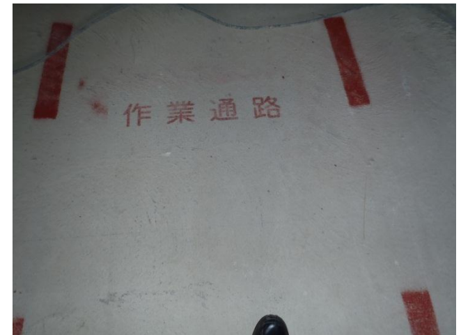
床に作業通路明示
