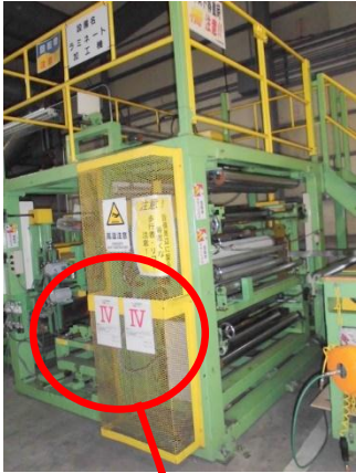
巻込まれ危険箇所
