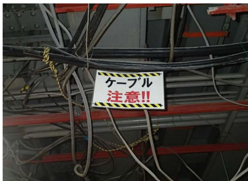
『重要設備 接触厳禁』、『ケーブル注意!!』看板を設置して重要な設備ということを作業員へ周知し、作業時にこれらに接触しないように見える化とした。
