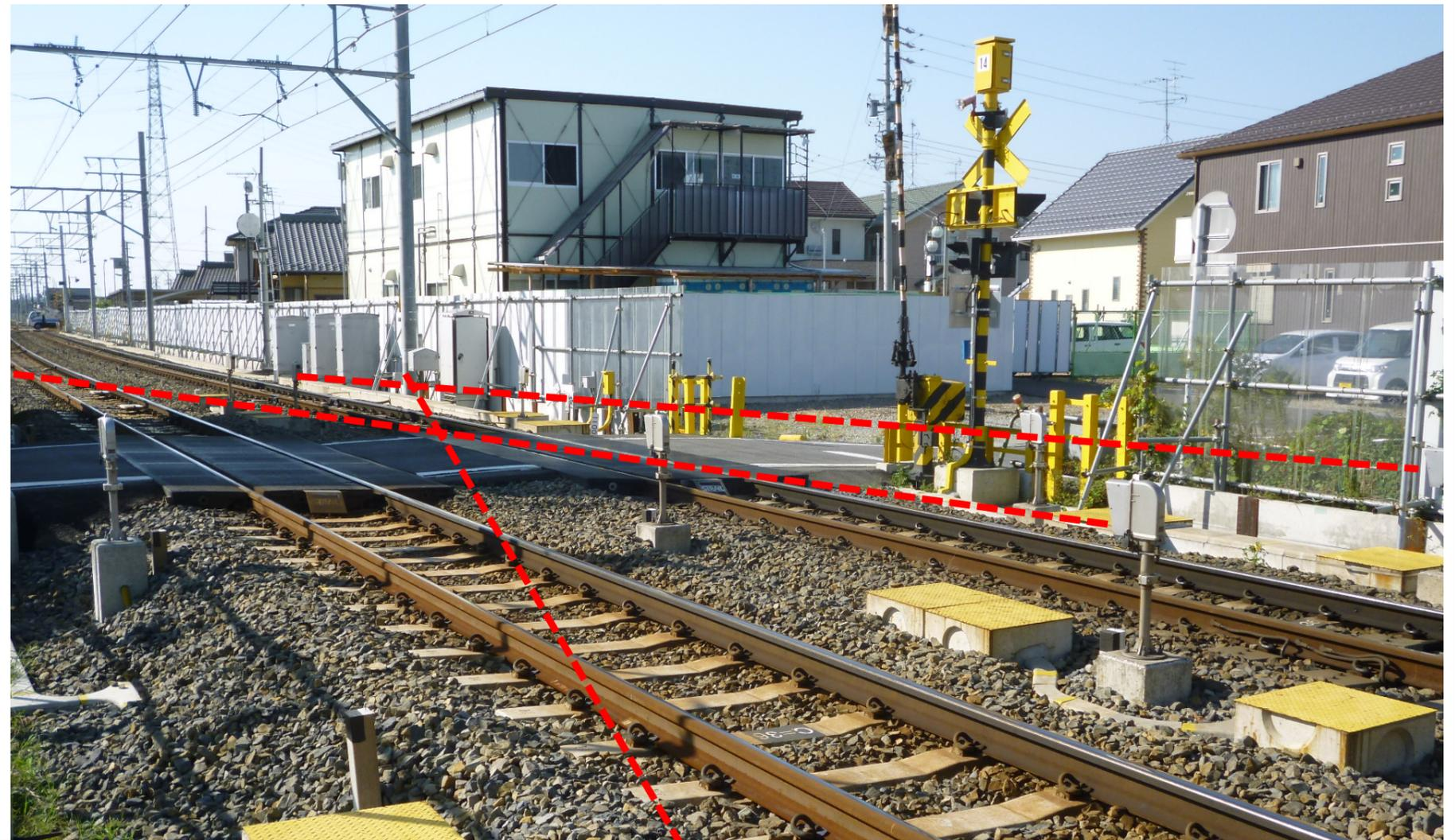
踏切が稼働すると赤点線のようにセンサーが作動する。
