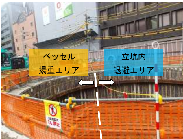
写真-2 プラチェーンによるベッセル(3m 3 )揚重エリアと立坑内退避エリアの明示(立坑外)
