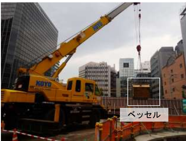
写真-1 クレーンとベッセル(3m 3 )吊荷状況
