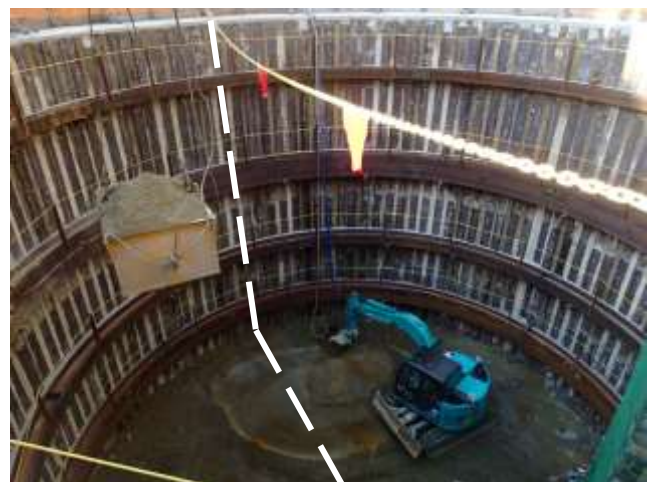
写真-3 プラチェーンによるベッセル(3m 3 )揚重エリアと立坑内退避エリアの明示(立坑内)
