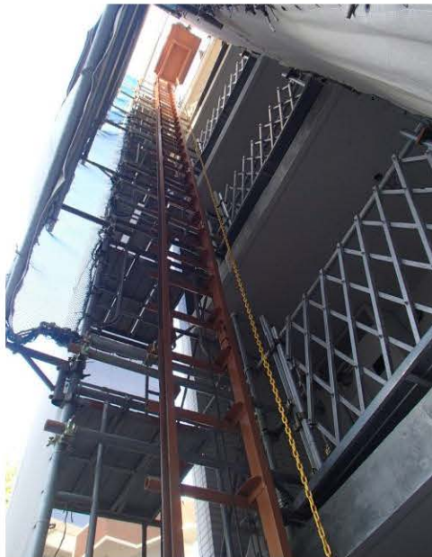
③位置確認のためのぞきこむと 飛来落下事故の危険がある
