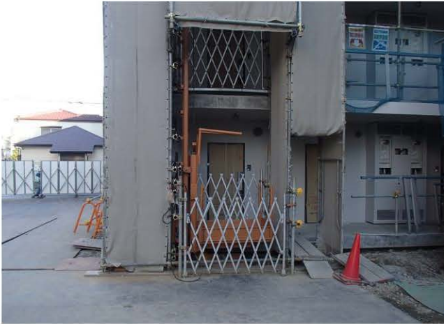
①工事用リフト(遠景)
