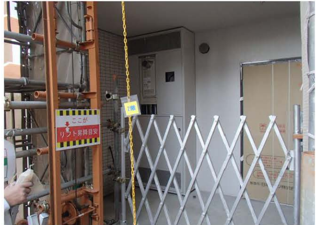
④リフト下部にチェーンを取付け 階数表示をすることで位置を把握する
