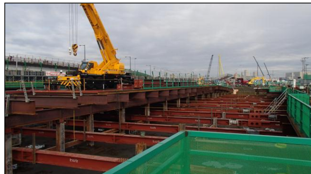
高所巡視台の設置（例②；仮囲い沿いにh=2.0mの巡視回廊を設置）
