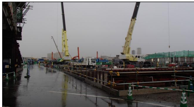
高所巡視台の設置（例①；工事用道路を一部拡幅）
