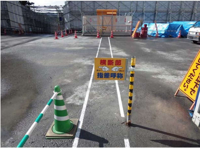
導線横断箇所 スイング式看板設置
